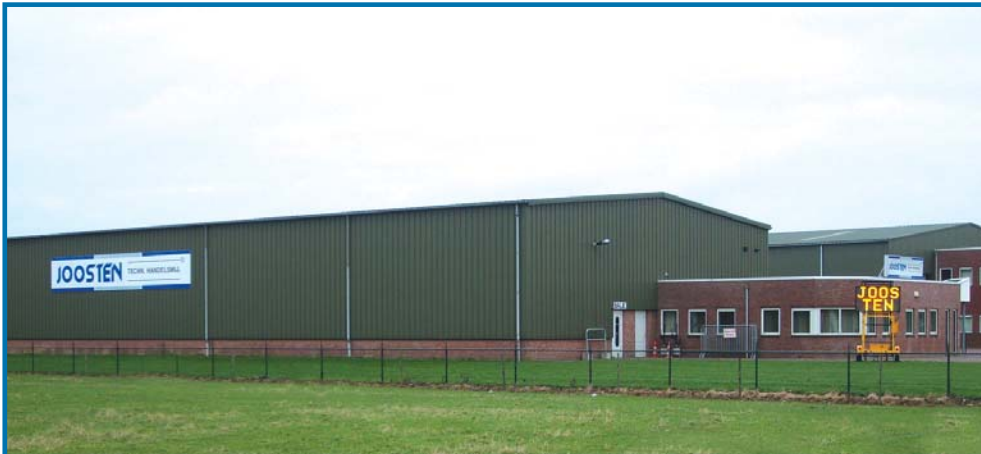
Kantoor en magazijn te Oosterhout (Gld)
